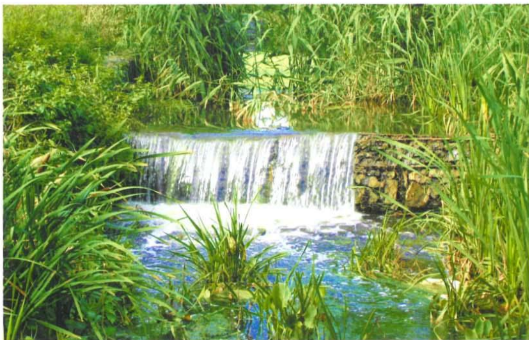
Рис. 1. Фрагмент фильтрующего водоёма из габионных конструкций
