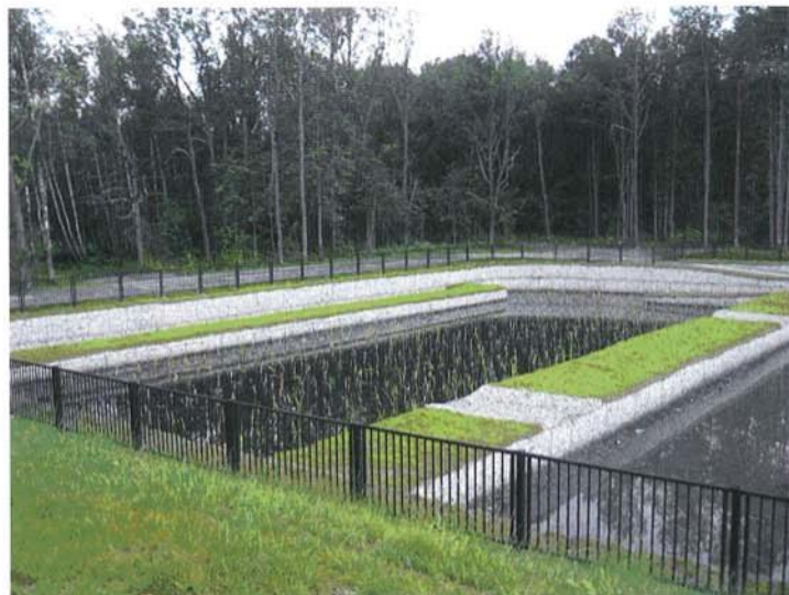
Рис. 4. Биоплато и фильтрующие камеры с песком и сорбентом
