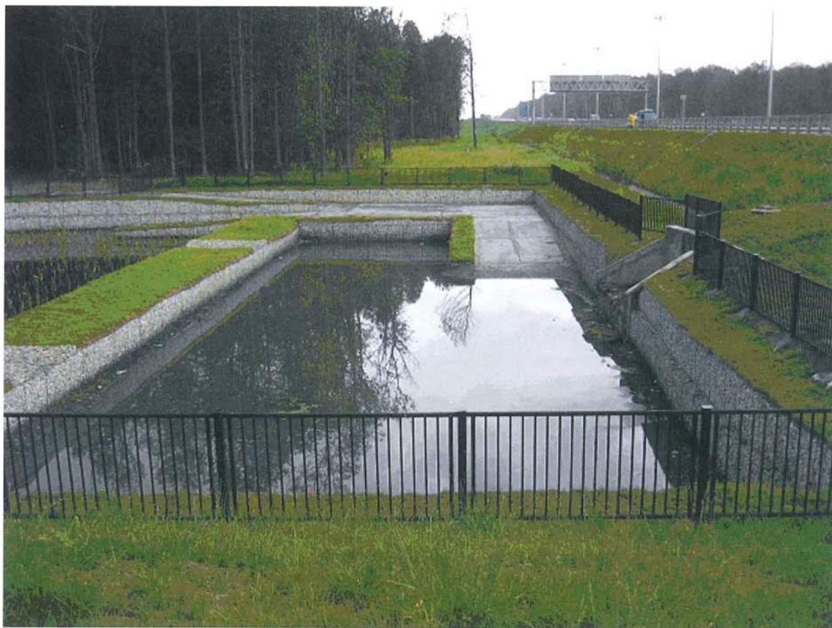
Рис. 3. Отстойник и фильтрующая камера с песком
